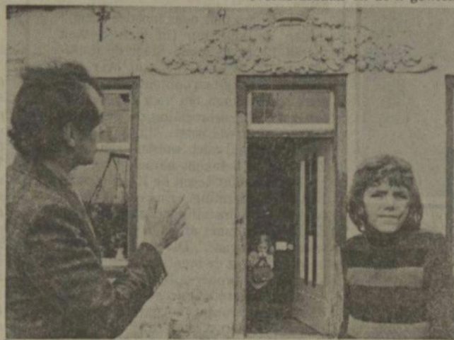
In de voorgevel van de boerderij „Klinkenborg” in Kantens herinnert een wapen van de familie Lewe nog aan de oude borg, die voor 1837 op deze historische plek heeft gestaan. Vader en zoon Holtman , beide geïnteresseerd in de geschiedenis weten heel wat te vertellen over die oude borg.
